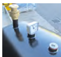
Механический уровень и фильтр на основе активированного угля. Mechanical level gauge and activated carbons vent filter.
